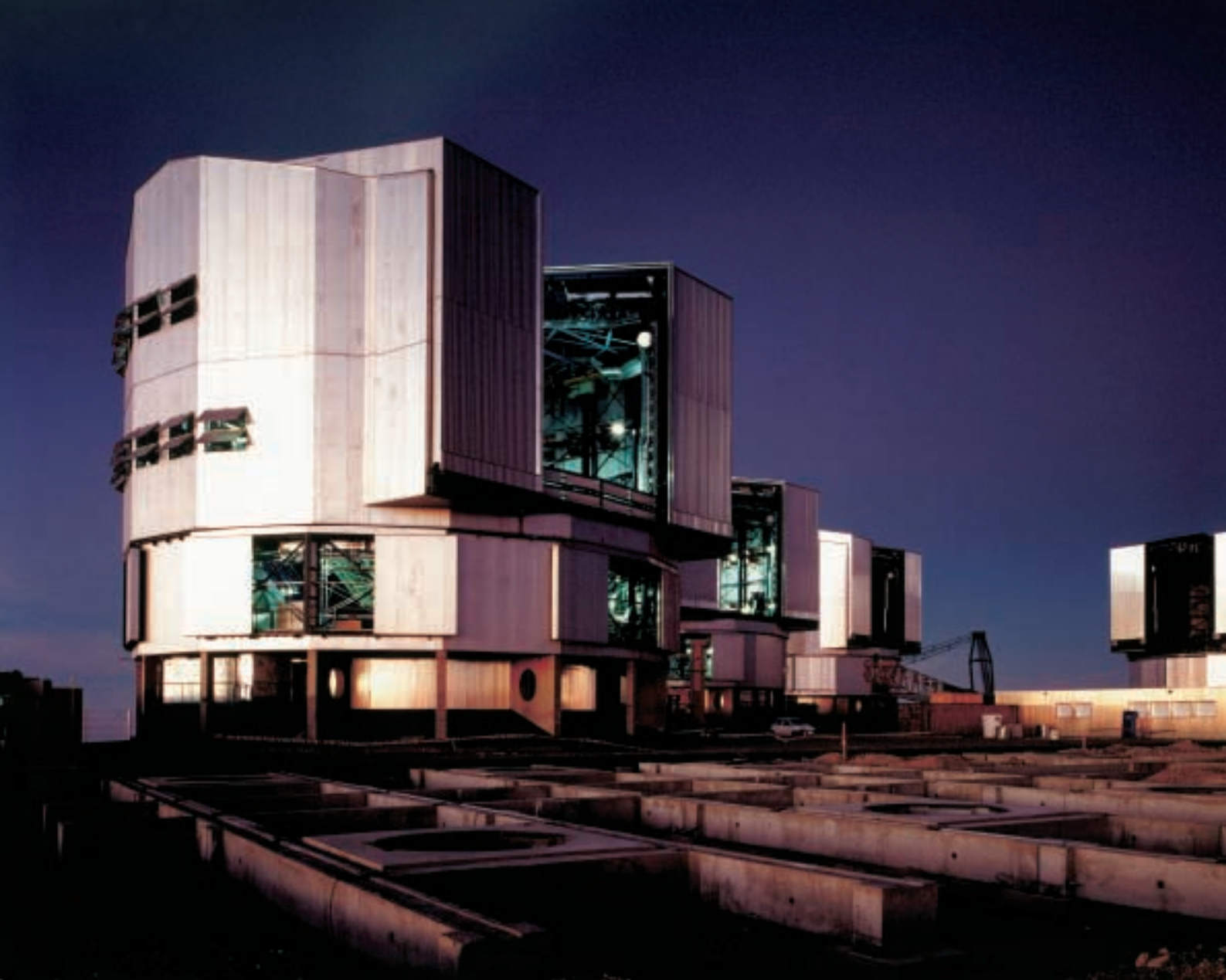
Abb. 2.: Das Very Large Telescope (VLT) der ESO befindet sich auf dem 2600 m hohen Cerro Paranal in der chilenischen Atacama Wüste, wo ausgezeichnete Sichtverhältnisse herrschen. Die gesamte Anlage, die aus vier 8,2-m-Hauptteleskopen sowie mehreren auf Schienen beweglichen 1,8-m-Hilfsteleskopen besteht, stellt zurzeit das grösste optische Teleskopsystem der Erde dar. Neben exzellenten Einzelbeobachtungen mit jedem individuellen Teleskop, besteht die Möglichkeit, das Licht aller Komponenten mit Hilfe der kleineren Teleskope zu interferieren. Dadurch lassen sich Bildqualitäten erzielen, die denen eines einzigen virtuellen Teleskopes mit einem Spiegeldurchmesser von 200 m entsprechen. Dieses erfordert eine mechanische Stabilität des Systems von weniger als 1 \mu\text{m} , eine der herausragenden Leistungen moderner Beobachtungstechnik. Bild: ESO
