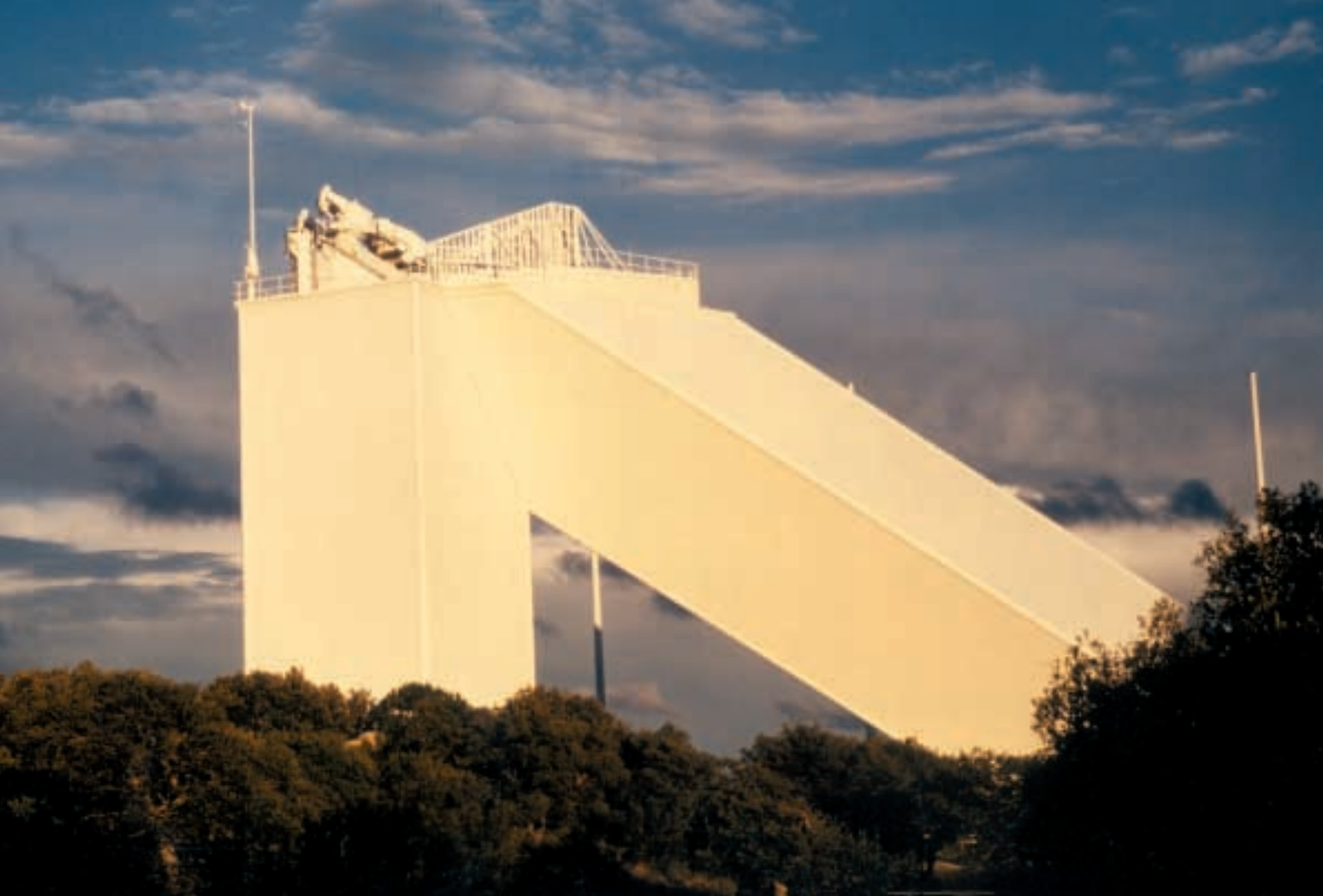
Abb. 5: McMath-Pierce-Sonnenteleskop auf Kitt Peak, Arizona. Mit einem Spiegeldurchmesser von etwa 1,5 m und einer Brennweite von rund 80 m ist es das grösste Sonnenteleskop der Welt. Das Institut für Astronomie der ETH Zürich führt hier mit seinem ZIMPOL-System regelmässig Beobachtungen durch.
